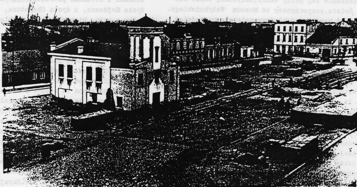
Budowa drogi przez rynek w Opatówku
